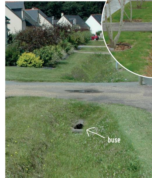
L'ouverture de «La Guêpe» implique l'aménagement de passages pour la traverser, sous forme de pont ou de buse.
