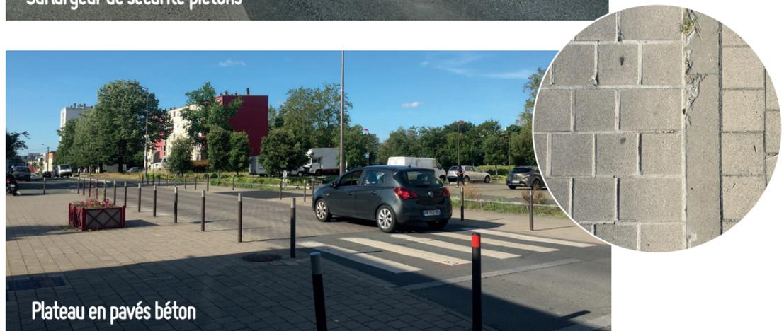
Plateau en pavés béton
