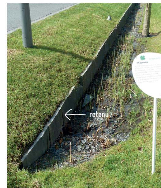
Si la pression est trop forte dans le fossé, mettre en place un mur de soutènement.
