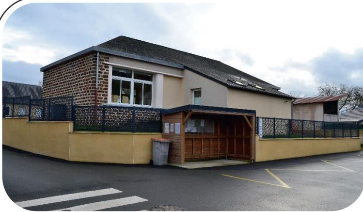
L'opération totale comprend : la démolition du mur en pierre existant, la construction d'un mur parpaing surmonté d'une palissade aluminium, un portail, un portillon, un interphone, l'enfouissement de la cuve gaz, un abris-bus.
