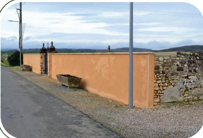
Le mur en pierre du cimetière, dégradé, a été remplacé par un mur en parpaing sur 25 m de long. Ce chantier a débuté en juillet 2019 pour se terminer sous le présent mandat, en octobre 2020.
